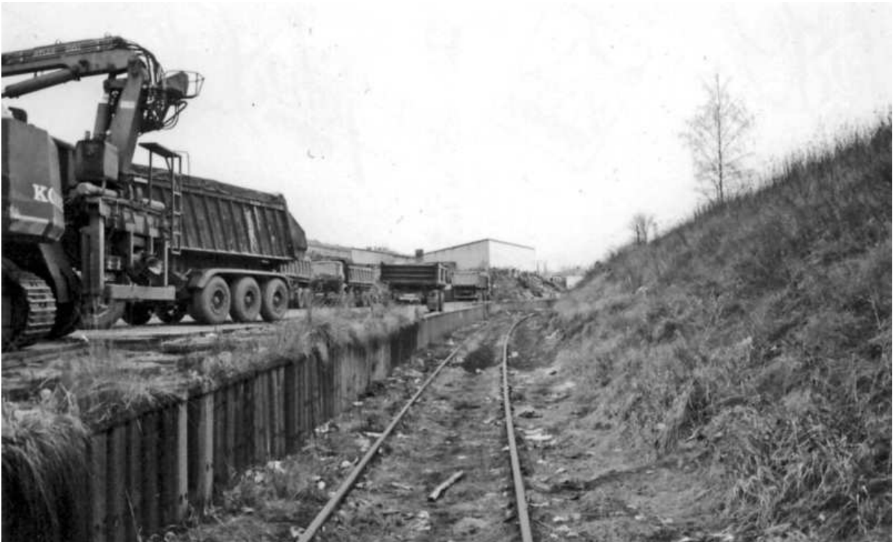
Abb. 6: Gleise und Deportationsrampe des Gleises 69 Güterbahnhofs Moabit, Januar 1993, Foto: Andreas Szagun
