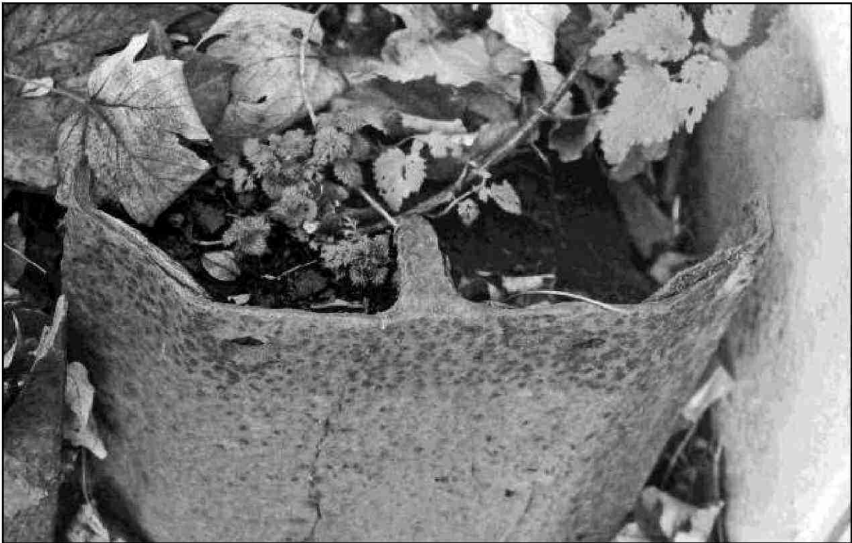
Bild 9 Laderampe Gleis 69. Die Laderampe besteht aus senkrecht eingerammten ehem. Langschwellen der Bauart „Hilf“ (siehe Abbildung 7 a - c), nach oben durch ein Winkelprofil (teilweise nicht mehr vorhanden) abgeschlossen und größtenteils mit Pflanzen durchsetzt. Zum Teil erhalten. Dezember 2015, 41119-1012-15-9650.
