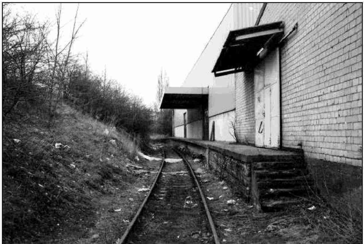
Bild 8 Gleis 69, Blick nach Osten. Links der Bahndamm der Ringbahngütergleise, rechts die Lagerhalle der Firma ATEGE, Gleisabschluß im Hintergrund. Das Gleis zu dieser Zeit noch in Benutzung. Damm, Gleis und Lagerhalle nicht erhalten. Januar 1993, 0218-01-93-31.
