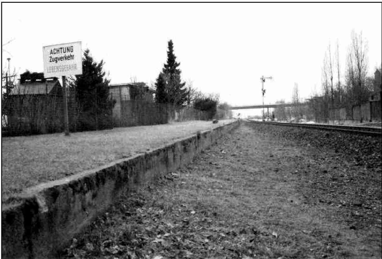
Bild 6 Spitze der Ladestraße mit Kleingartennutzung, Blick nach Westen. Bordkante und Trasse des ehem. Gleises 82. Das sichtbare Gleis rechts ist das Streckengleis HuL – Moa, das im Bereich des Signales nach dem zweiten Weltkrieg anders trassiert worden ist, im Hintergrund die Putlitzbrücke. Bahnanlagen und Kleingärten nicht erhalten. Januar 1993, 0218-01-93-28.
