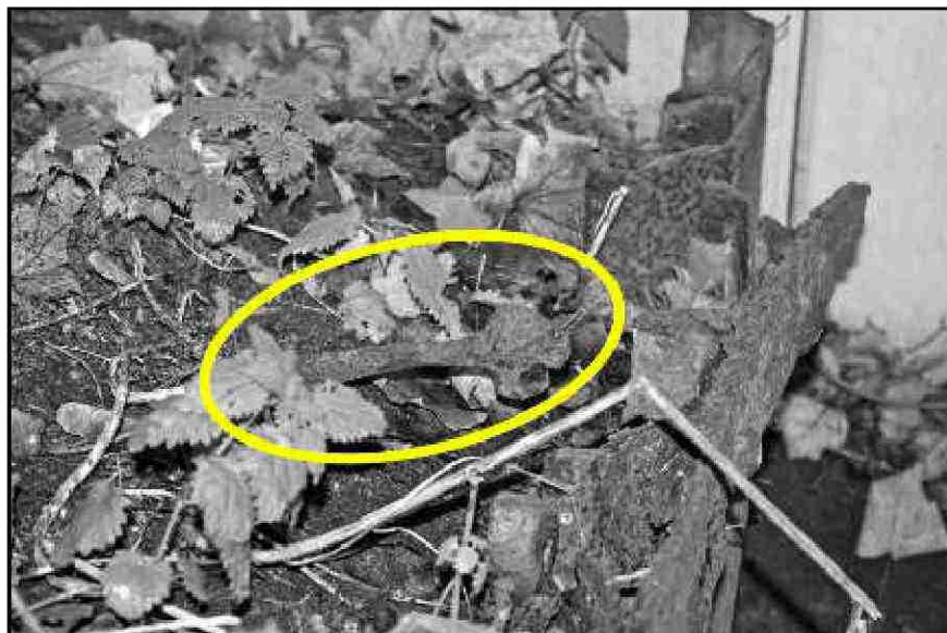
Abbildung 10: Rückverankerung der Laderampe
