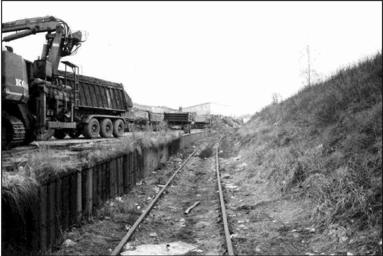
Bild 7 Laderampe und erhaltenes Gleis 69, Blick nach Westen. Links die Rampe, als Lagerplatz eines Baustoffhändlers genutzt. Rechts der Bahndamm der Ringbahngütergleise. Das Gleis 69 ist zu dieser Zeit noch befahrbar und zeitweise genutzt. Rampe erhalten, Damm nicht erhalten. Januar 1993, 0218-01-93-30.
