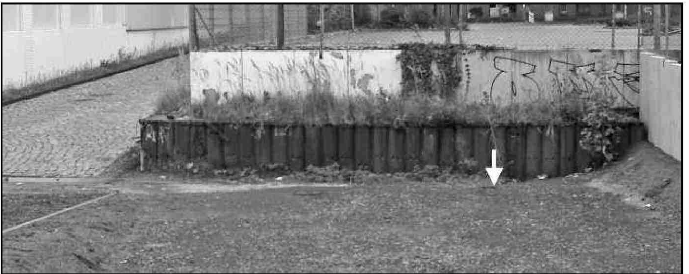
Abbildung 8 b: Unpassend abgetrenntes und teilweise verschüttetes Gleis, Aufnahme am 18.10.2009
