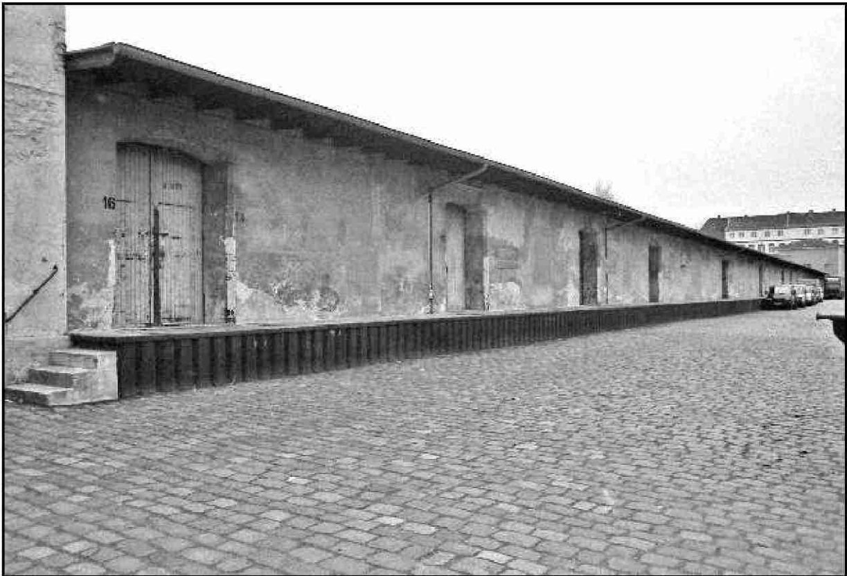
Bild 15: Rampeneinfassung des Güterschuppens auf dem Hamburger Bahnhof, Heidestraße. Nicht erhalten. Januar 1999, 0689-01-99-16A
