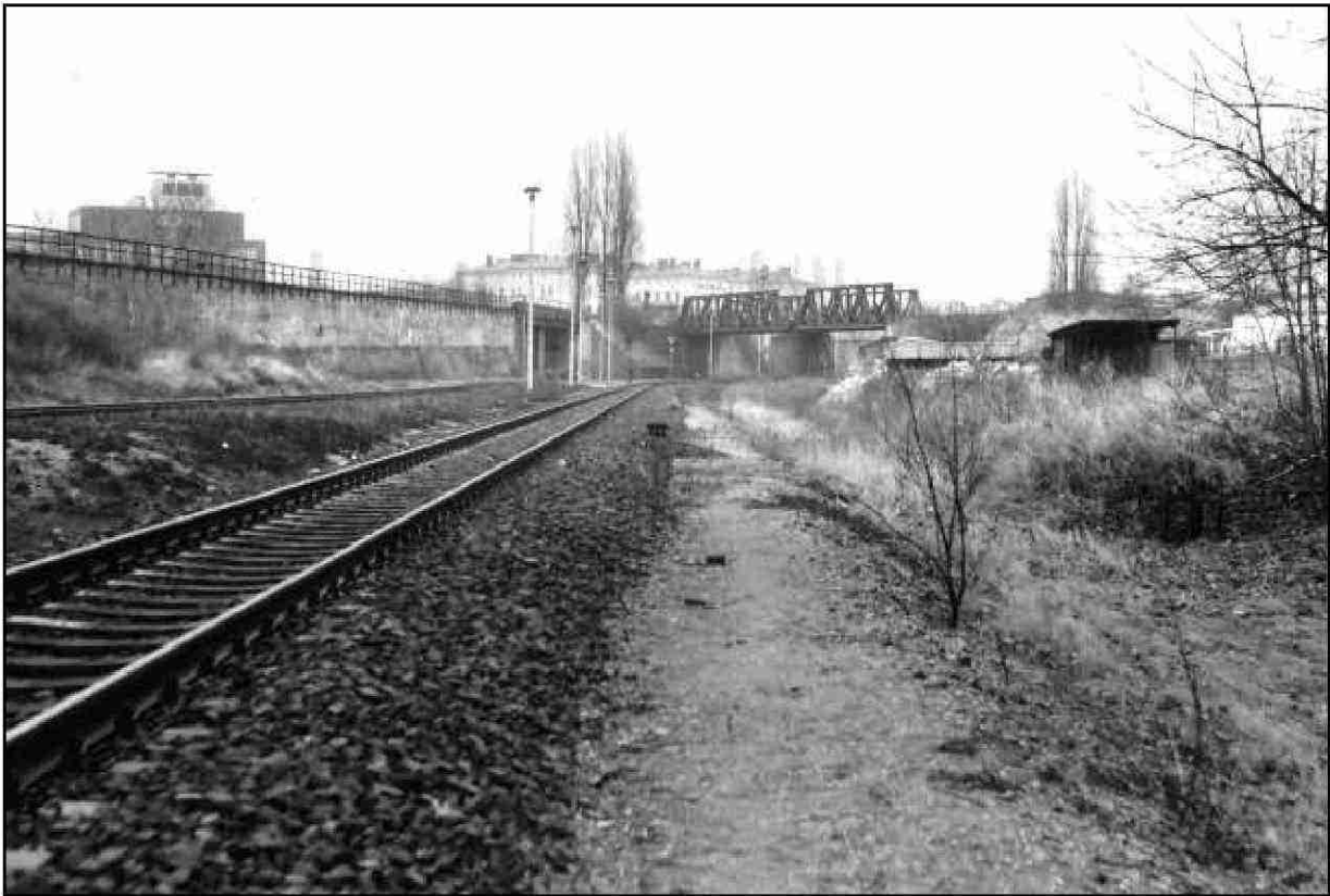
Bild 11 Bereich östlich der Ladestraße, Blick nach Osten. Ganz links auf dem stützmauergesicherten Bahndamm die S-Bahn-Ringgleise, in der Mitte das Streckengleis HuL-Moa, im Hintergrund die beiden Brücken zur Überführung der Ringbahngütergleise über die Einfahrtgleise des Hamburger und Lehrter Bahnhofs. Der östlichste Teil der Ladestraße ist zugewachsen. Nicht erhalten. Januar 1989, 0106-01-89-11.
