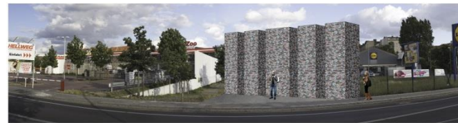
VOIDS | Panoramablick von der Elber-Eisen-Station
